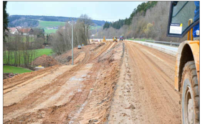
Große Erdbewegungen; am Straßenrand geht es steil bergab.
