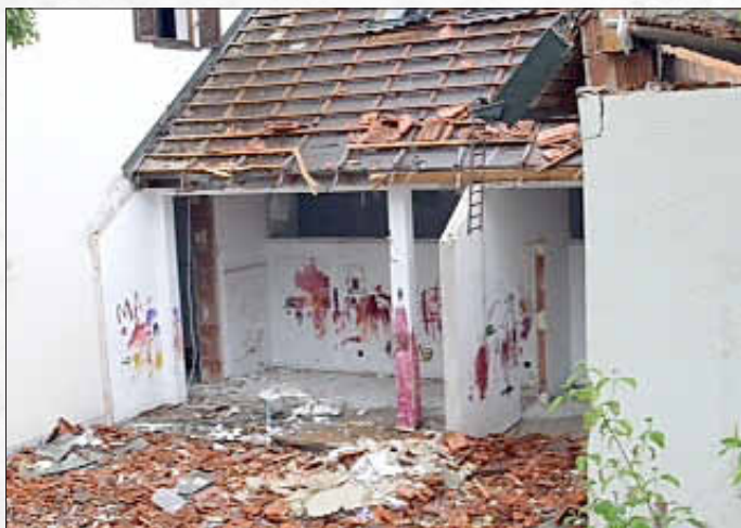
Die Abbrucharbeiten sind in vollem Gang
