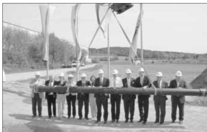
Die Ehrengäste vor dem Einbau des letzten Abwasserrohres
