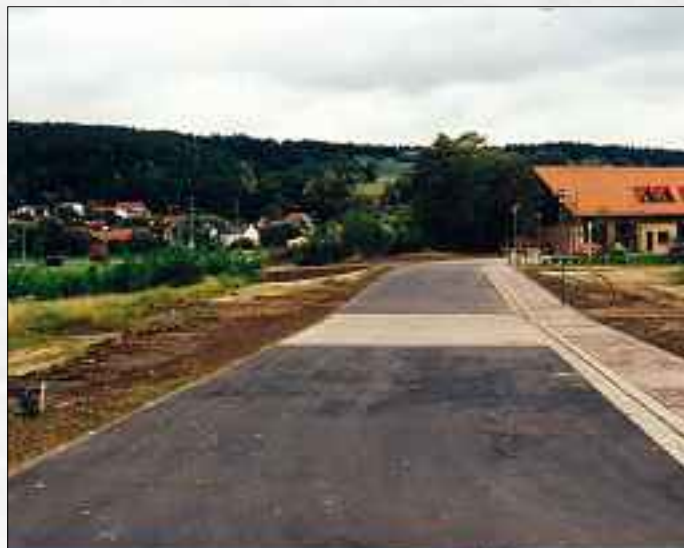
Bahngelände mit Erschließungsstraße im Jahr 1993
