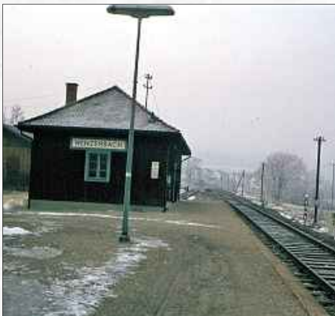
Bahnhof und altes Lagerhaus um 1983
