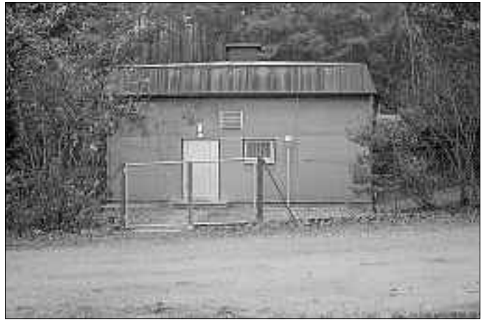
Hochbehälter Tradl 1980/81 erbaut, Inhalt 1000 cbm Wasser, im Jahr 2009 saniert
