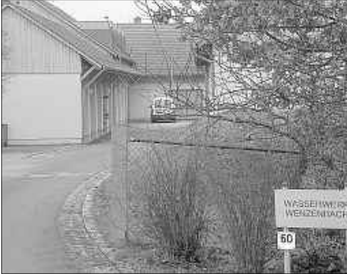
Das neue Maschinenhaus ist seit März 2003 in Betrieb.
