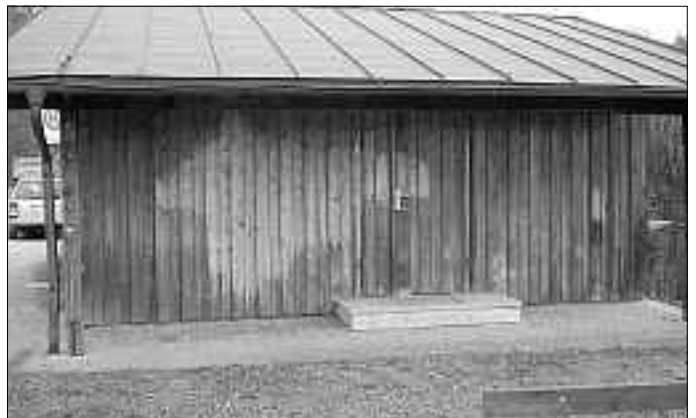
Das Drucksteigerungspumpwerk ist wegen der Höhenlage des Baugebietes erforderlich. Sein Inhalt: 2 x 75 cbm
