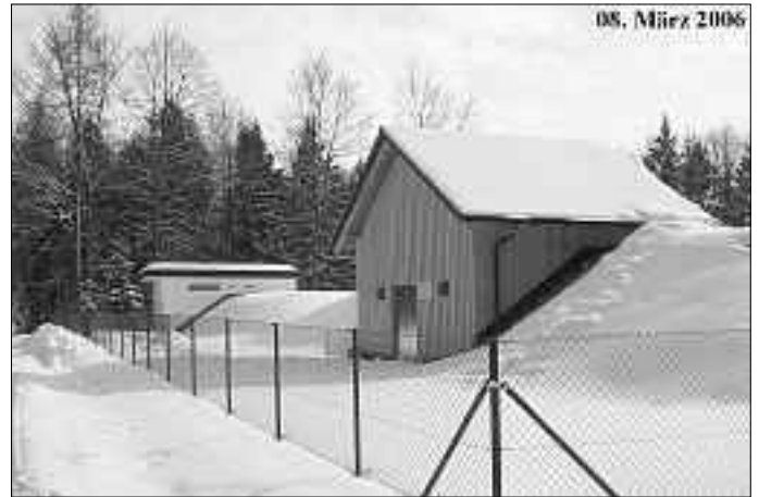
Hochbehälter Forstacker: 1964/65 erbaut mit einem Inhalt von 200 cbm, - im Jahr 2005 um 1000 cbm erweitert
