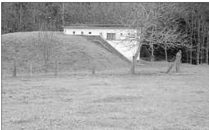
Hochbehälter Birkenhof: in Betrieb ab Ende 1962, Fassungsvermögen 300 cbm
