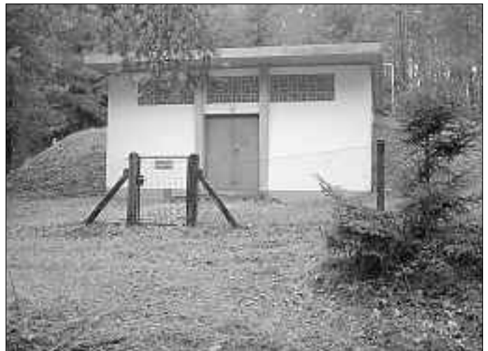
Hochbehälter Irlbach: erbaut 1964/65, Inhalt 200 cbm
