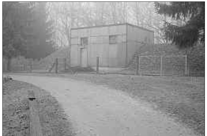
Hochbehälter Kürn: Baubeginn 1963, Füllung mit 500 cbm Wasser 1964
