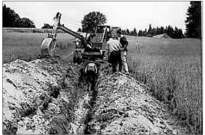
Im Jahr 1963 wird mit dem Leitungsbau nach Kürn begonnen: Grabungen auf einem Feld bei Steinrinnen
