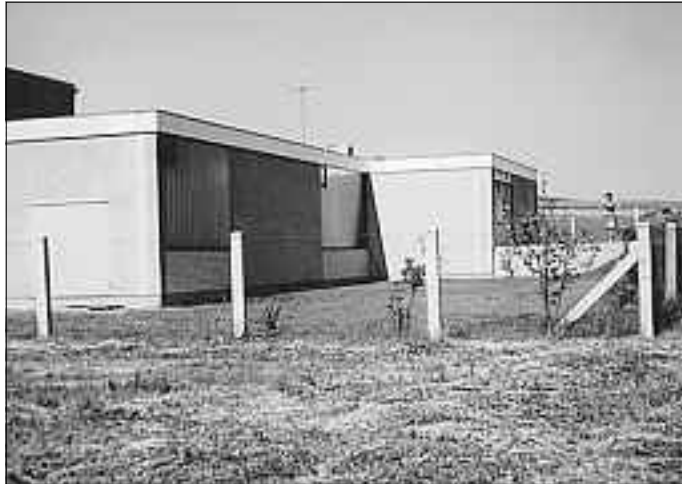
Außenansicht des 1966 eingeweihten Maschinenhauses, damals noch mit Flachdächern versehen
