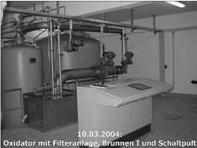
Blick in das neue Maschinenhaus
