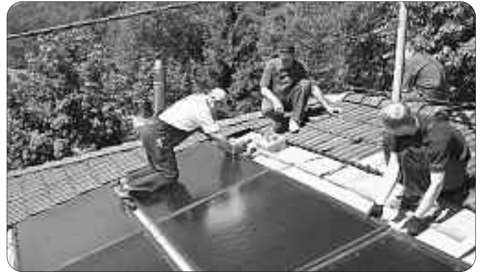
Ein Quadratmeter Kollektorfläche für zehn Quadratmeter Wohnraum reicht, um zehn bis 30 Prozent des Heizwärmebedarfs abzudecken. Foto: Weishaupt-interPress
