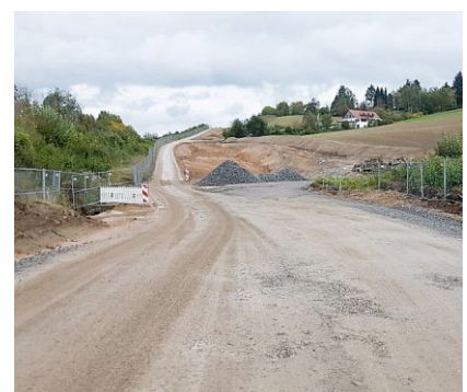
Baustelle der Südspange
